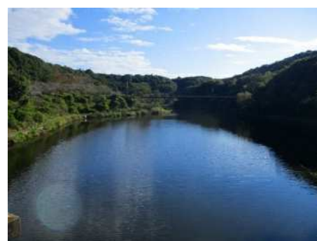
増沢調整池越しの吊橋
