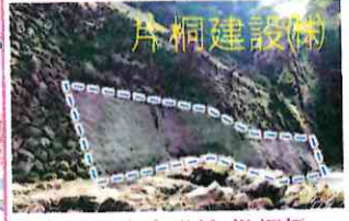
片桐建設(株) ②(主)天竜東栄線(枇杷橋) モルタル吹付工完了 R7年2月末解除予定
