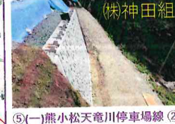
㈱神田組 ⑤(一)熊小松天竜川停車場線 ② 擁壁工施工中 R7年3月末解除予定
