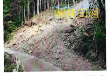
㈱神田組 ⑦(一)熊小松天竜川停車場線 ④ 再被災につき復旧工法変更 R7年3月末解除予定
