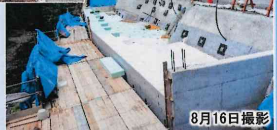
軽量盛土工施工中 （11段中の9段目）
