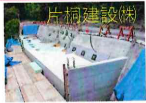
片桐建設(株) ①(主)天竜東栄線(大栗安) 軽量盛土施工中 R6年9月末解除予定
