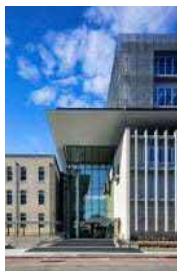
魔法瓶型の内箱構造、空調系統を2系統とし故障時のバックアップ対策を施した鉄骨造の施設
