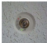
(バッテリー内蔵式非常用照明装置の例)
