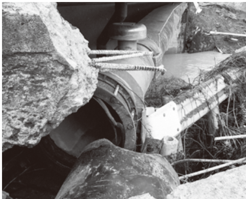
(写真上) 令和5(2023)年8月に中央区伊左地町で起こった、水管橋の部品損傷による水道水の噴出
