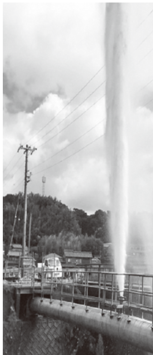
(写真上) 令和5(2023)年8月に中央区伊左地町で起こった、水管橋の部品損傷による水道水の噴出
