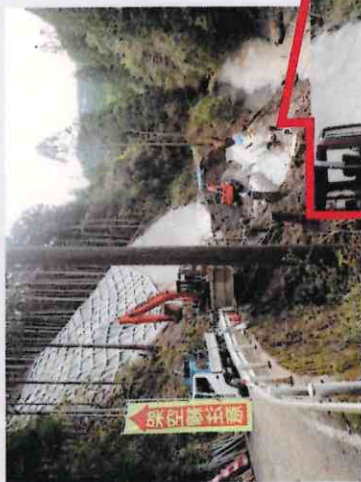
大型ブロック積工、施工中
