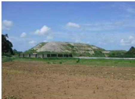
＜農地に造成された無許可盛土事例＞
