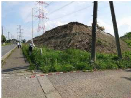
＜道路沿いに造成された無許可盛土事例＞
