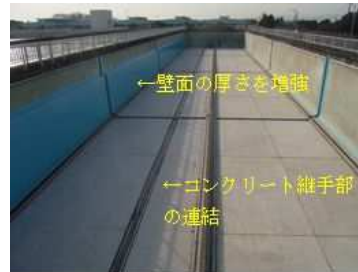
〔参考〕沈澱池の耐震化
