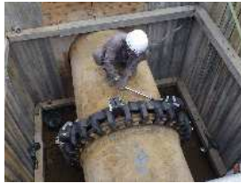
〔参考〕継手補強
