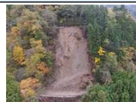
山間部における土砂崩れ
