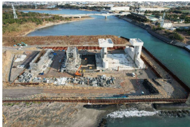
水門整備工事の様子
