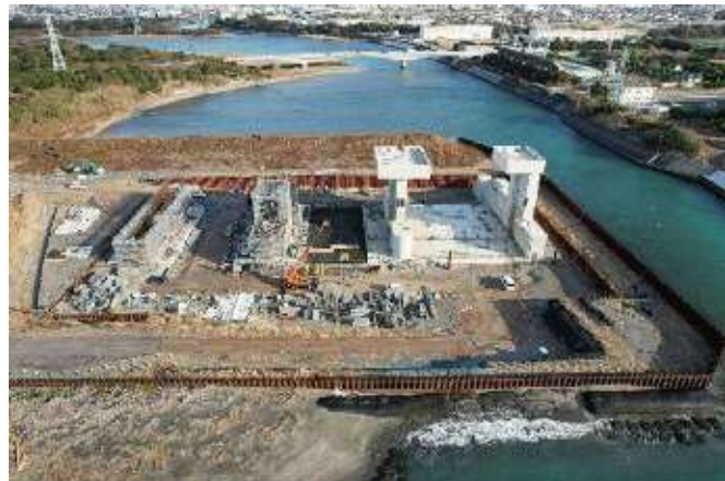
水門整備工事の様子
