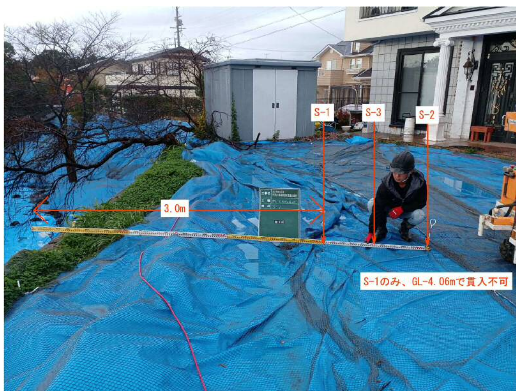
写真7.3.1 スクリューウエイト貫入試験実施箇所（撮影：2022年11月26日）
