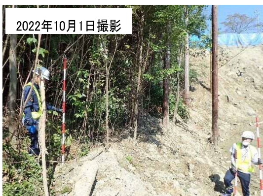
写真-7.1.5 盛り土部周縁斜面の状況
