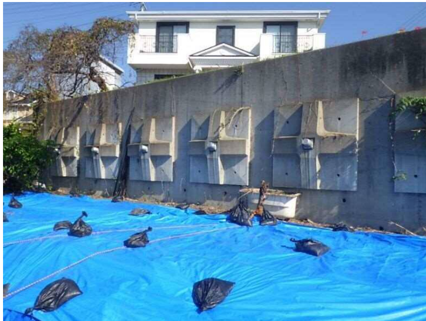
写真-7.1.4 斜面上方宅地 造成状況（2022年10月1日撮影）
