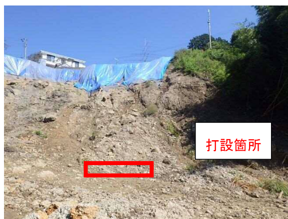
図-7.2.1 横ボーリング工 打設箇所
