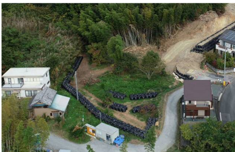
写真-6.2.1 沈砂池（2022年11月7日撮影）
