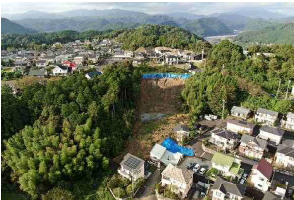
写真 1.1 被災状況 (令和 4 年 9 月 25 日撮影)
