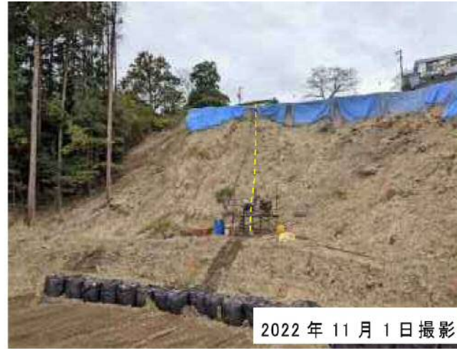
写真-4.3.5 副測線 B-M 付近の斜面状況
