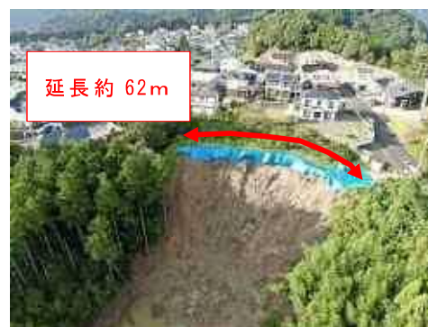
写真-2.2.1 崩落後地形 (2022年9月25日撮影)
