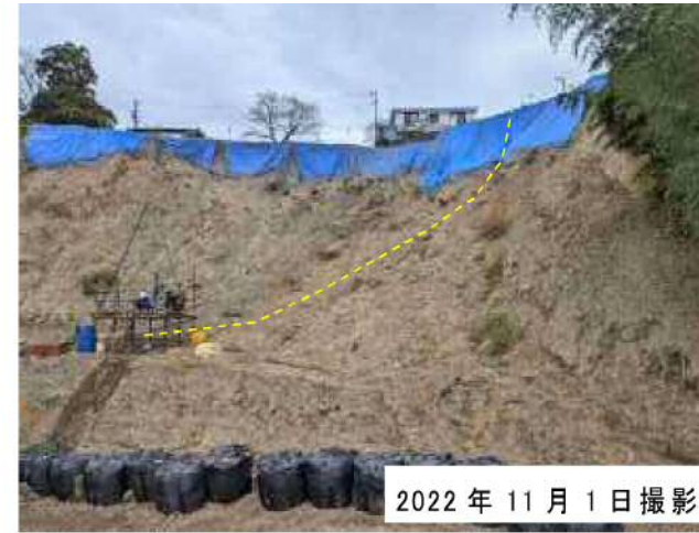
写真-4.3.6 副測線 C-M 付近の斜面状況
