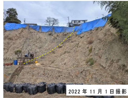
写真-4.1.1 主測線付近の斜面状況
