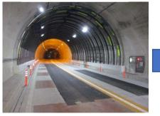
トンネル内壁の剥落を 防ぐため仮設材を設置
