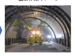
亀裂を補修し トンネル内壁を補強材で覆う
