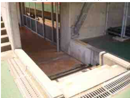
【UD化非対応】 選手控室への進入路
