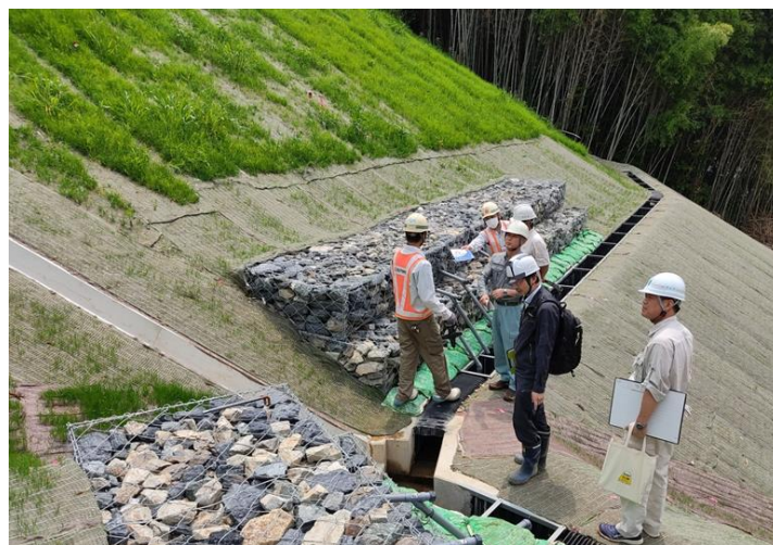
写真：技術的検証委員による緑恵台現場確認状況
