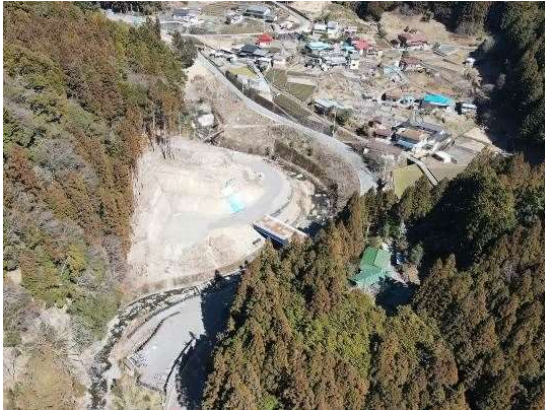
▲国道152号(池島～大原)(仮称)1号橋付近
