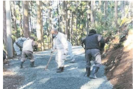
▲原材料支給事業による道整備の様子
