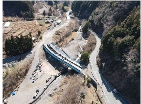
▲国道152号(池島～大原)(仮称)10号橋付近
