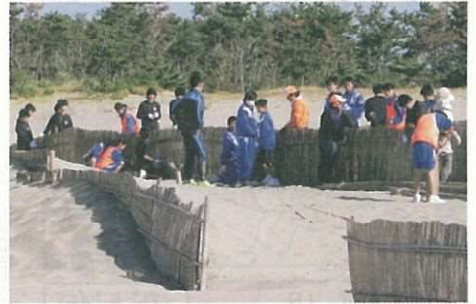
今年は、80mの堆砂垣を8本設置した
