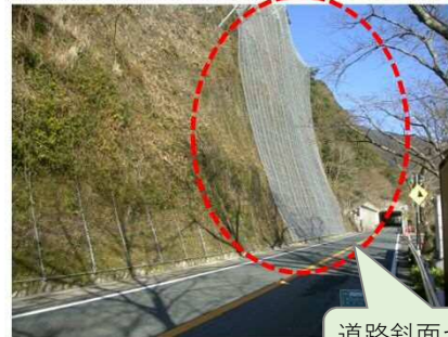
対策後 (平成29年6月完成)
