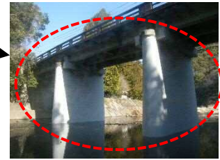
橋脚補強 (国道362号麓橋 平成26年3月完成)
