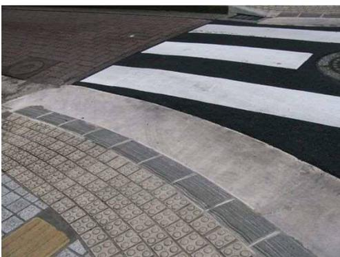
□ 溝の幅 9mm 以下の側溝の事例
