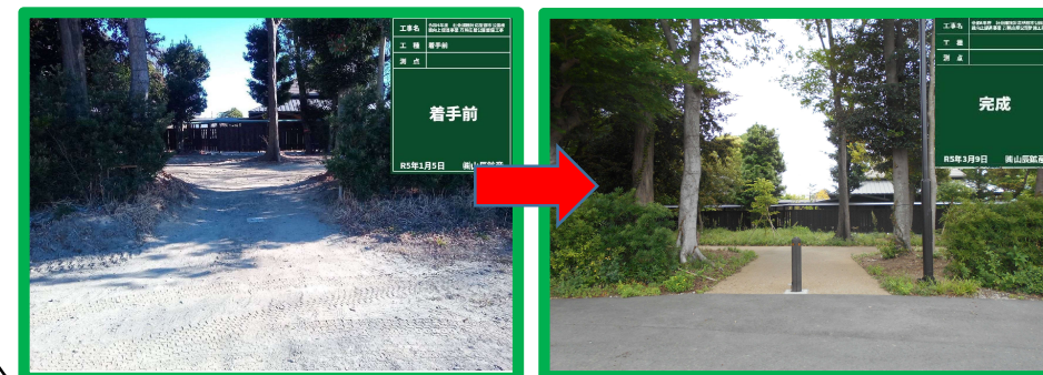
③西から東を望む 砂利道園路→西側出入口と園路(透水性舗装)
