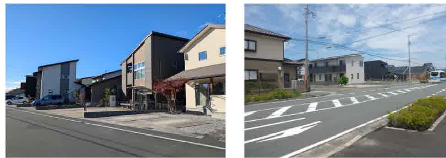
図 耐震性の高い住居が並ぶまちなみ 前面道路も拡幅され乗り入れやすさが向上し、質の高い居住空間が形成された
