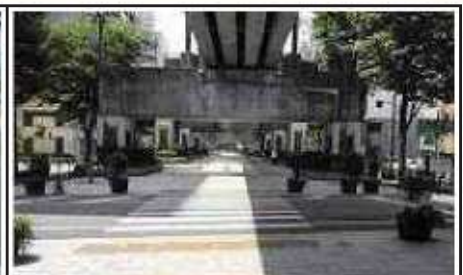
鉄道高架下を活用した開放的な歩行者空間 （中区・鍛冶町通り～万年橋）
