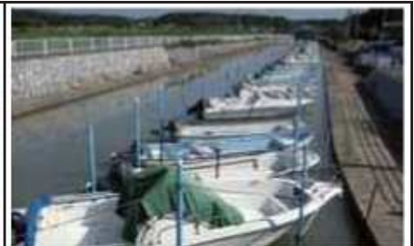
係船施設完成状況 (西区・協和排水路)
