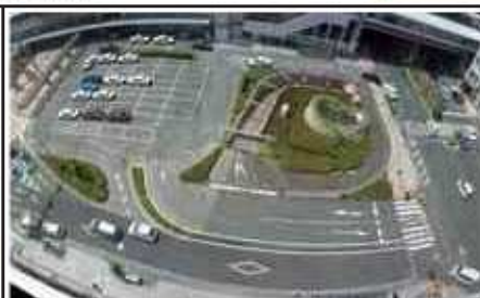
改良が予定されている JR浜松駅南口（現況）
