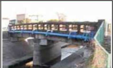
防食工事により、 錆びや漏水が防止された水道管
