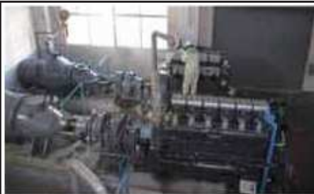
河川管理事業 (ポンプ場の点検状況)
