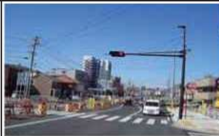
自動車交通の整流化を図る 環状線の整備（整備中）
