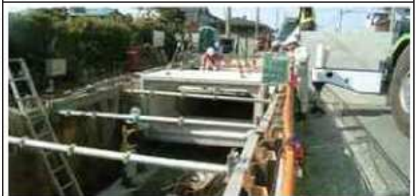
雨水処理のための都市下水道整備（整備中）
