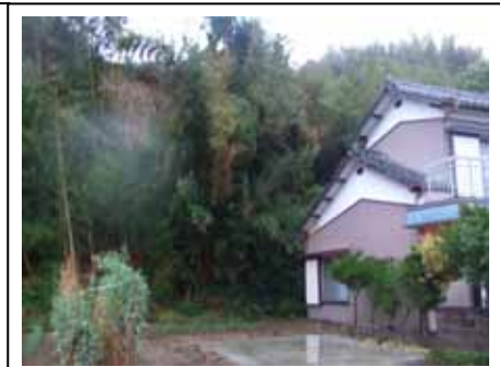
写真 土砂災害による危険箇所
