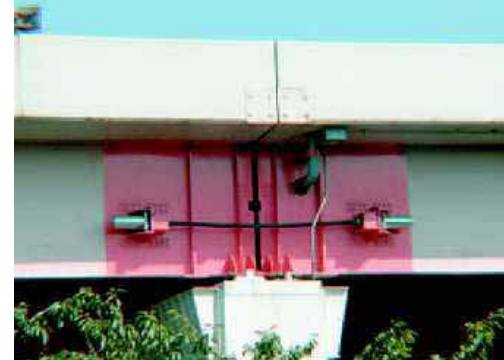
避難路の橋梁耐震
