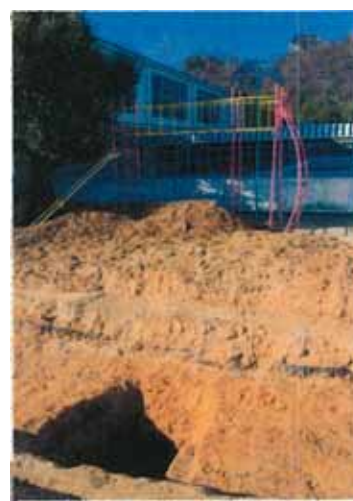
トレンチで確認した井戸 御誕生場にかかわる井戸とみられる。直径1.6m、深さ2.4m以上におよぶ。
