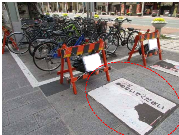
図 43- 駐車場の注意喚起標識の劣化状況
