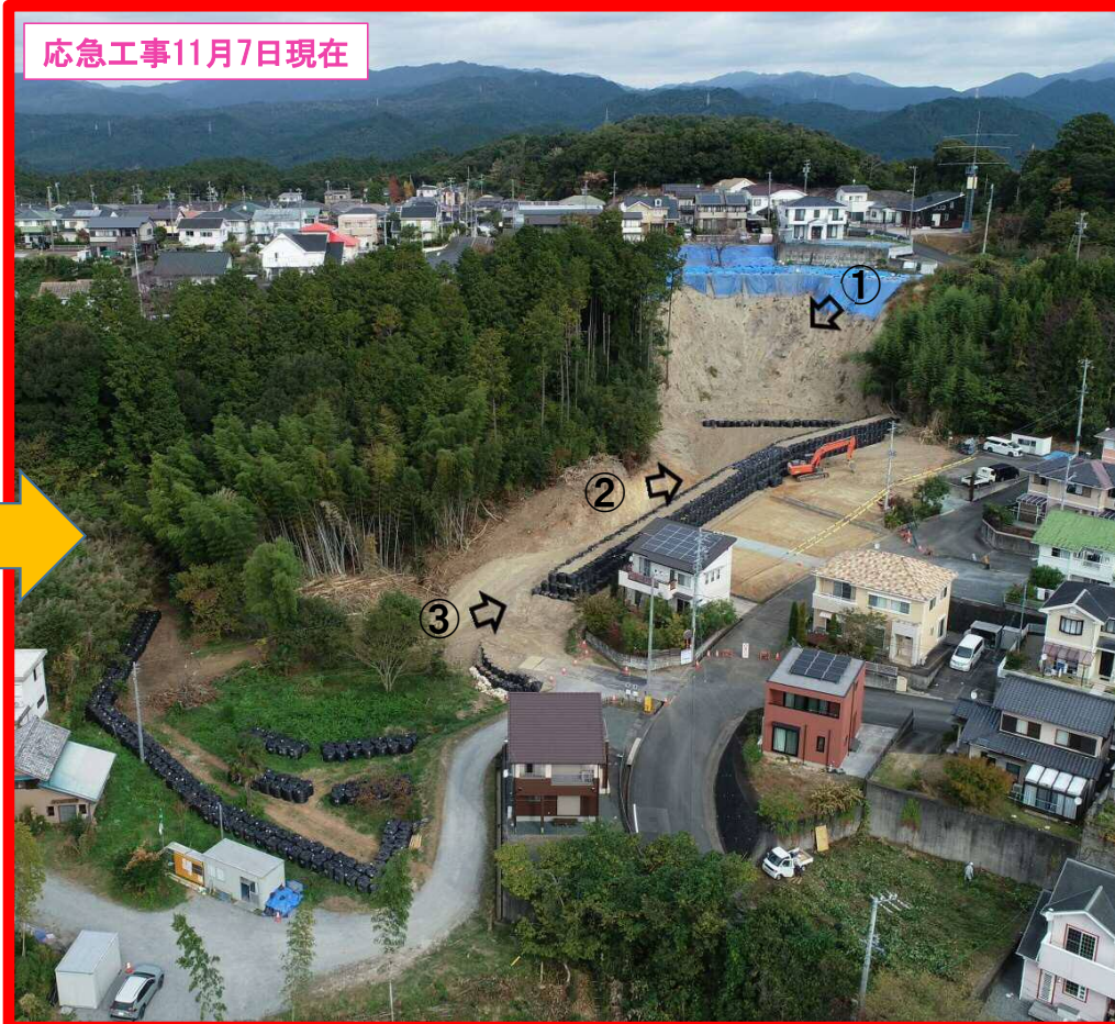
③土のう防護堤 完成状況 (下部)
