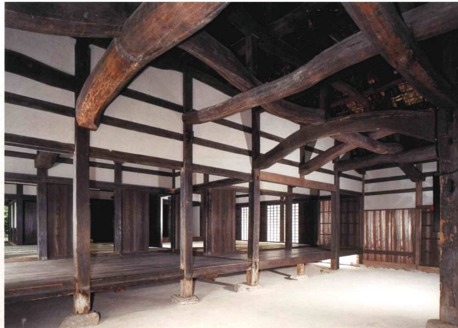
▲土間(南東隅)から床上部をみる
