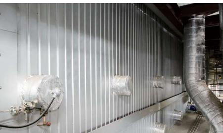
ごみをとかした時の熱で、水を蒸気にかえ、工場内の冷暖房やとなりにある水泳場 TOBiO の温水をつくることに利用する。また、蒸気タービンに送り発電する。
