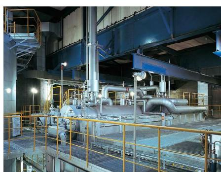
ごみをもやした時の熱で、水を蒸気にかえ、工場内の冷暖房、給湯などに使う。また蒸気タービンに送り発電する。
