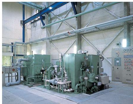
ごみをもやした時の熱で、蒸気タービンを回し、約6千軒の家庭で使える電気をつくる。
