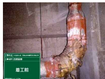
老朽化した設備系統
