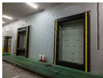
ドックシェルター付きトラックバース
