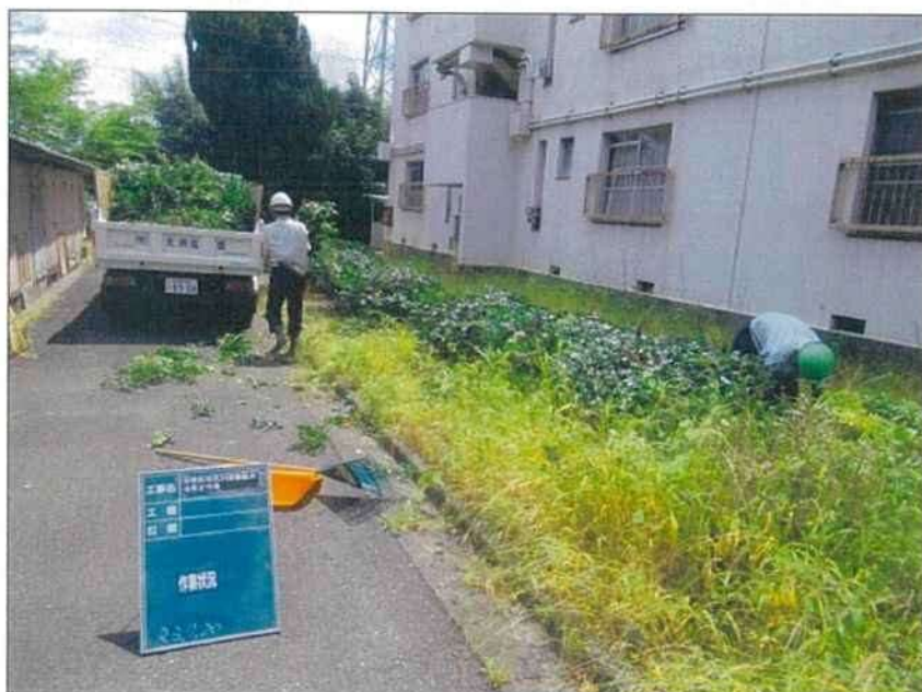
市営住宅花川団地 低木強剪定作業 作業状況 R3. 7. 20
