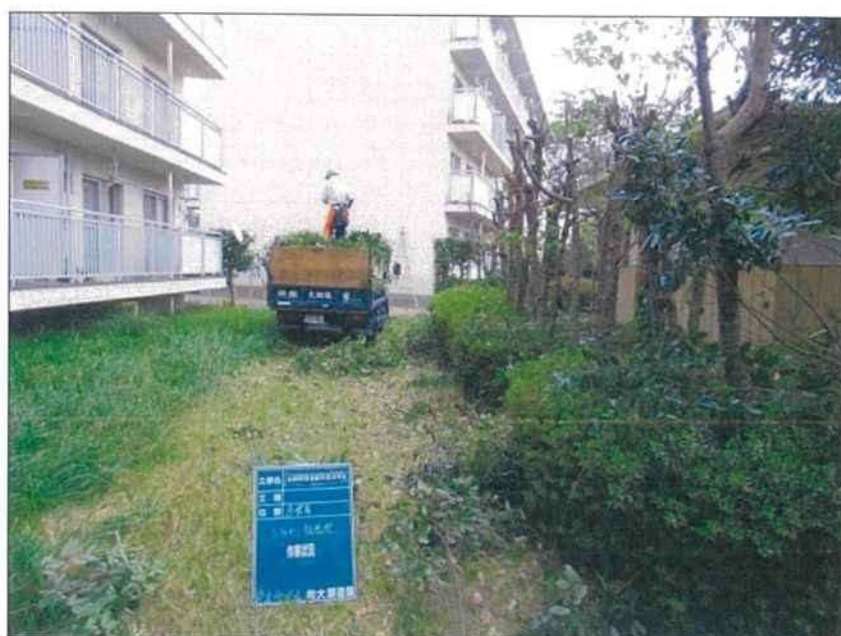
法師軒団地樹木剪定作業 シラカシ強剪定 B棟南側 発生材積込作業状況 R3. 10. 22
