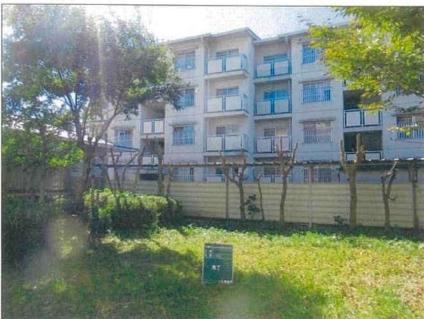
法師軒団地樹木剪定作業 シラカシ強剪定 B棟南側 完了 R3. 10. 23
