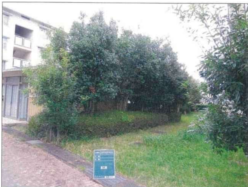
法師軒団地樹木剪定作業 シラカシ剪定 B棟南側 施工前 R3. 10. 22
