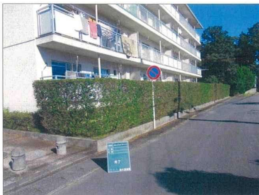
法師軒団地樹木剪定作業 サザンカ剪定 C棟南側 完了 R3. 10. 16
