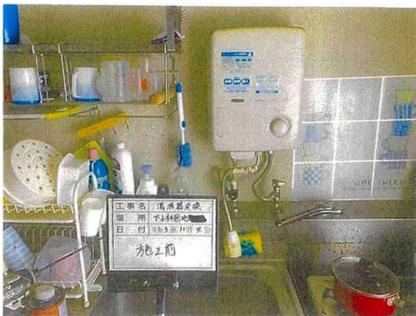
浜松市営下小林団地 号室 湯沸し器取替修繕工事
