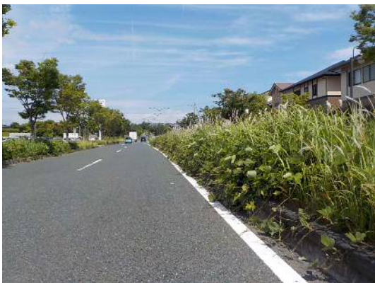
写真7 雑草が車道にはみ出した 中央分離帯の事例
