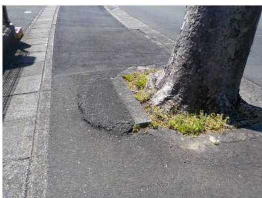
写真3 根上がりが発生している街路樹の事例
