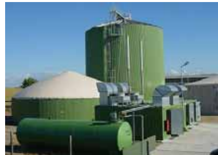
メタン発酵方式によるバイオガス発電施設 （農林水産省ホームページ）
