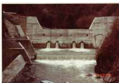
砂防堰堤の例(静岡県資料)
