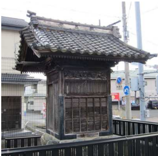
小松秋葉山常夜燈覆屋（工事着手前）
