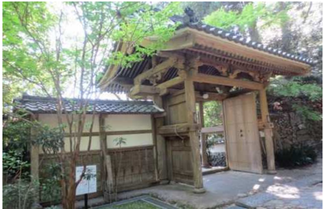
龍潭寺山門（裏面） 工事着手前
