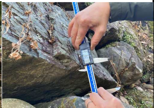
石垣安定度調査
