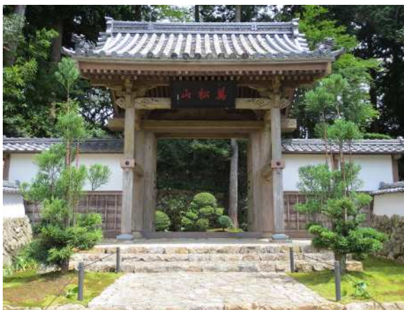
龍潭寺山門（正面） 工事完了後
