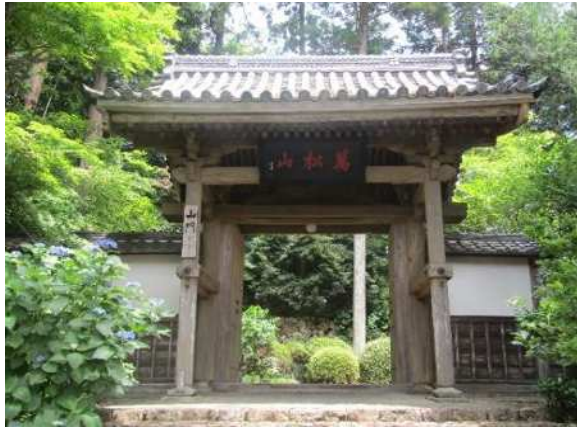
龍潭寺山門（正面） 工事着手前
