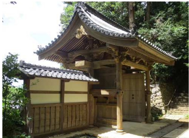
龍潭寺山門（裏面） 工事完了後
