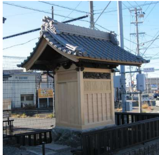
小松秋葉山常夜燈覆屋（工事完了後）
