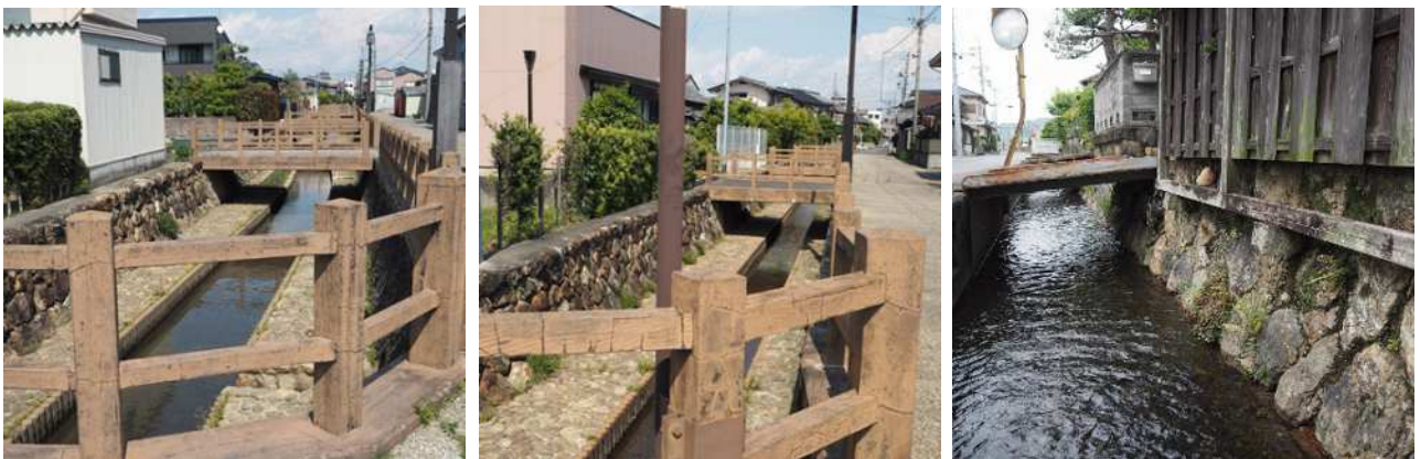
堀川(要害堀)周辺の現況
