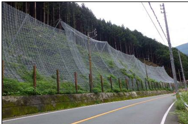
▲国道152号道路防災事業
