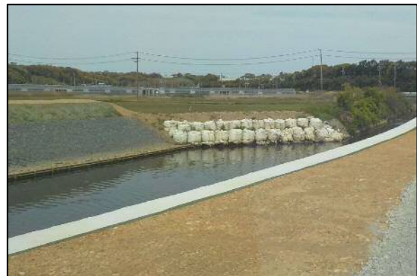
▲二級河川九領川河川改修事業
