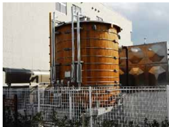
西区役所（浜松市雄踏町） 地域材で作られた木製の貯水槽です。
