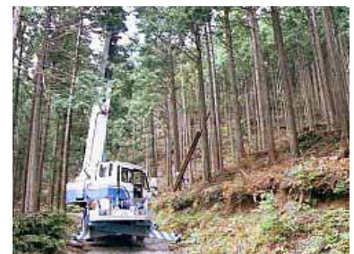
クレーンによる間伐材の搬出 （浜松市龍山町）
