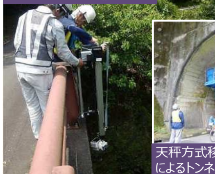
ロボットカメラによる橋梁点検
