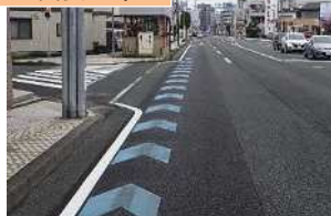
車道混在型自転車通行空間*（矢羽根型路面表示*）
