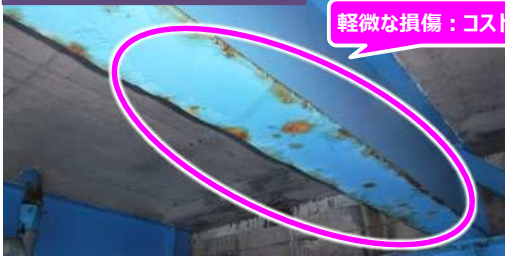
健全性Ⅱの事例（橋梁）
