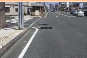
車道混在型自転車通行空間*（矢羽根型路面表示*）
