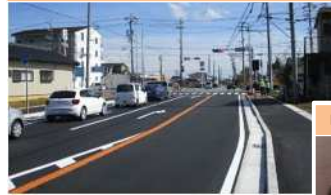
事故危険箇所* (右折レーン設置)
