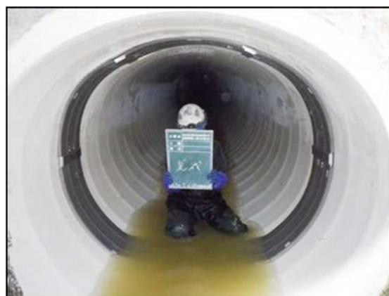
<改築後> 管更生を実施した管路
