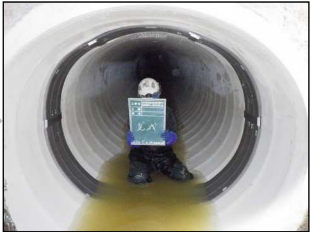
＜改築後＞管更生を実施した管路
