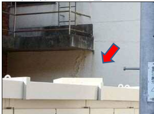
経年劣化による外壁のヒビ
