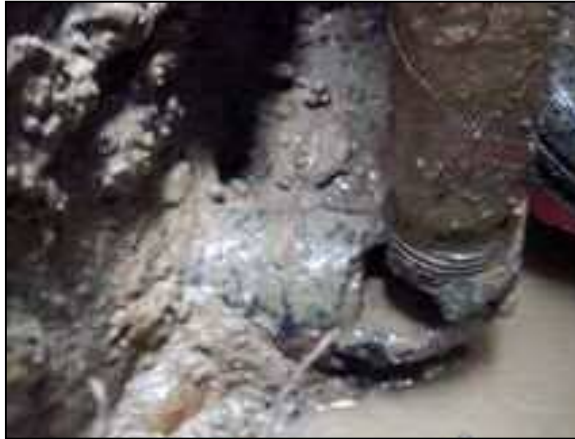
水道管の破裂による漏水
