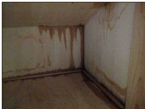
壁からの雨漏り
