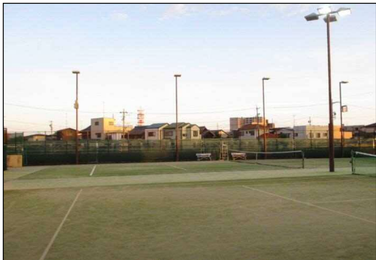
テニスコート フェンスの高さ不足
