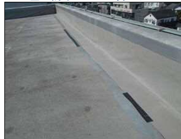
屋上防水シートの剥がれ
