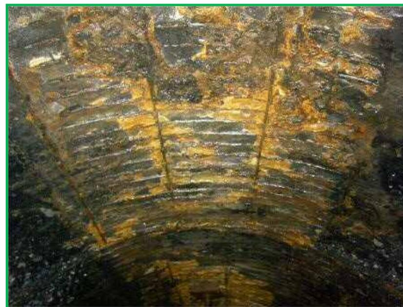
被覆するコンクリートが腐食し、網目状に設置された鉄筋がむき出しになり、錆びている状態
