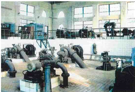
きゅうすみよしじょうすいじょう 旧住吉浄水場ポンプ室ほか（中区住吉五丁目、東区常光町：国登録有形文化財 建造物）
