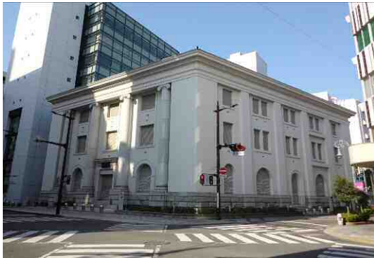
しずおかぎんこうはままつえいぎょうぶ きゅうえんしゅうぎんこうほんてん 静岡銀行浜松営業部<旧遠州銀行本店>（中区田町：市指定有形文化財 建造物）
