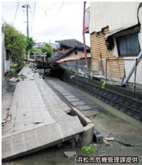
事例① ブロック塀の転倒
