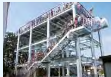
つ なみ ひなん 津波避難タワー
