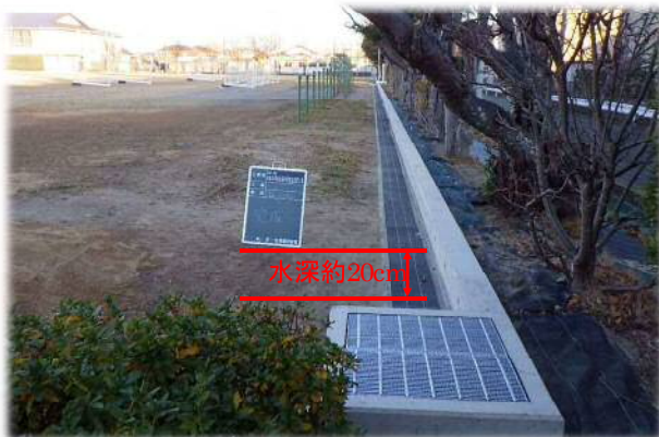
令和2年度施工箇所 (可美中学校)
