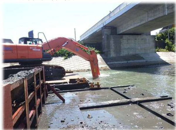
平成29年度 浚渫実施状況
