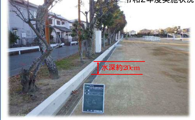
令和2年度施工箇所 (可美中学校)
