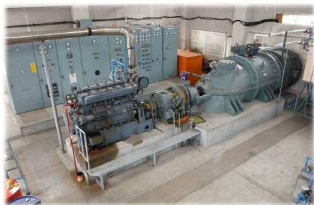
第1排水機場 ポンプ修繕・電気設備更新
