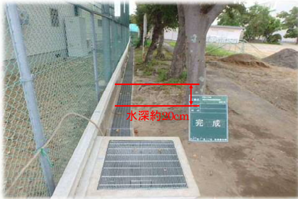
平成30年度施工箇所 (新津小学校)
