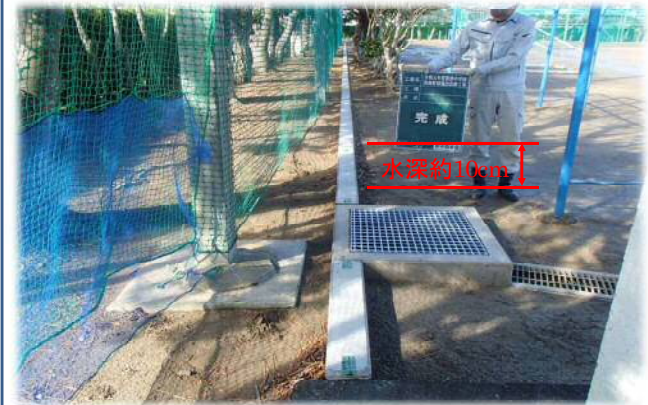
令和元年度施工箇所 (新津中学校)
