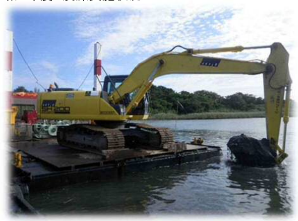
令和1年度 浚渫実施状況
