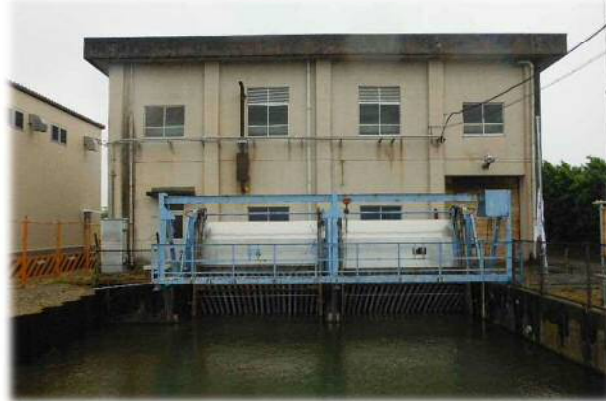
第1排水機場 除塵機更新
