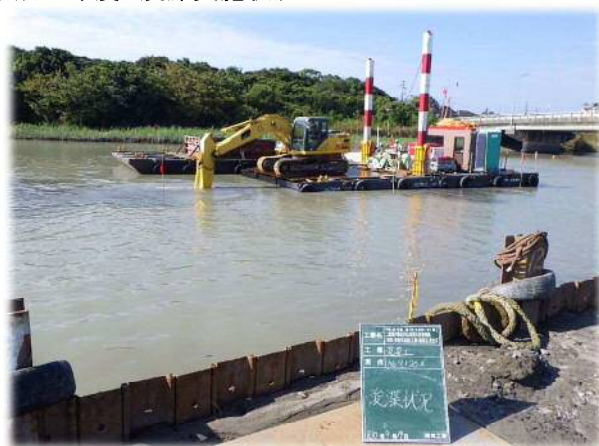
平成30年度 浚渫実施状況
