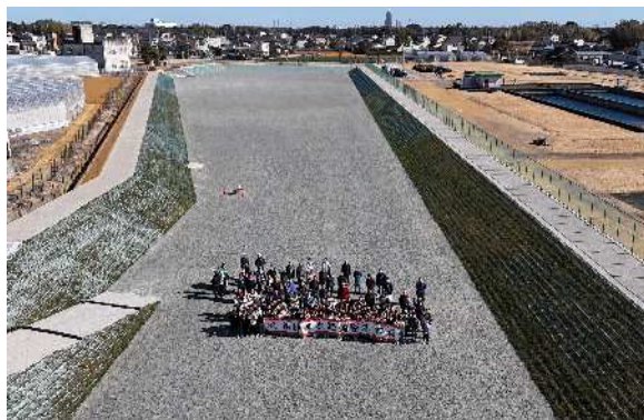
神原排水路調整池（中央区神原町・大久保町地内）
