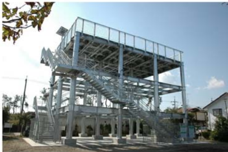
本町浜公園津波避難タワー (南区法枝町)
